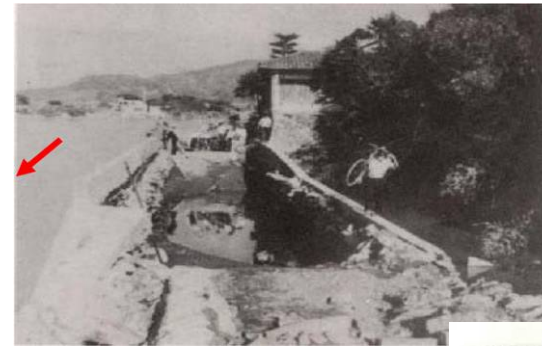
S28年9月洪水 おうづ 麻生津地区の被害状況
