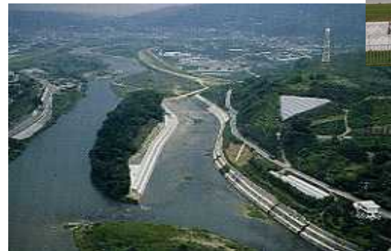
船岡山開削(和歌山県かつらぎ町) 平成元年度完了
