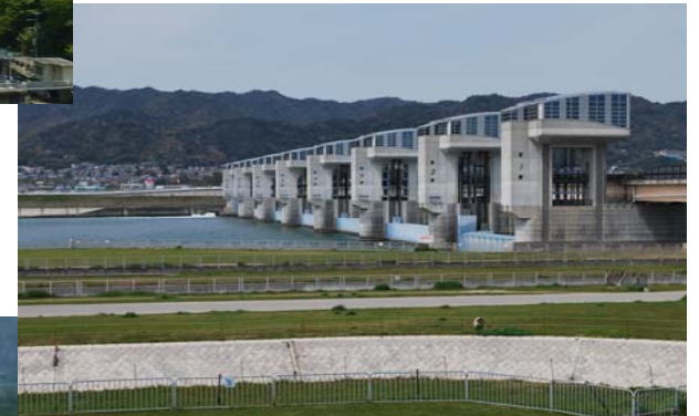
紀の川大堰(和歌山県和歌山市) 平成22年度完成
