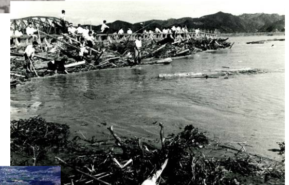
S34年9月洪水 和歌山市南海橋の被害状況
