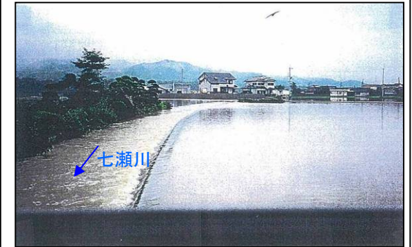
②平成7年7月出水状況
