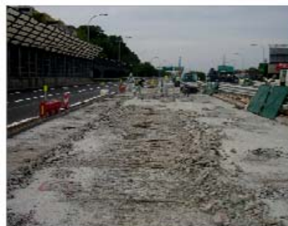
橋梁床版部の損傷状況
