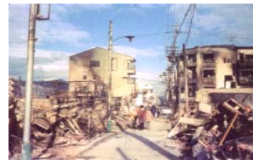
兵庫県南部地震の被災直後 (兵庫県神戸市兵庫区松本地区)
