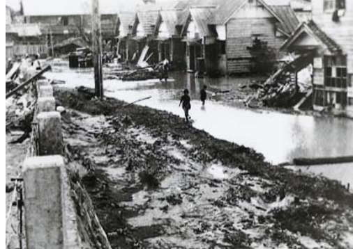
うんびん S28年洪水・小浜市雲浜地区の浸水状況
