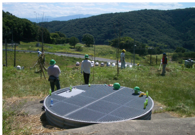
集水井周りも綺麗に草刈り
