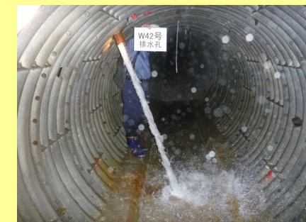
地下水を取り除いている様子 (排水トンネル)
