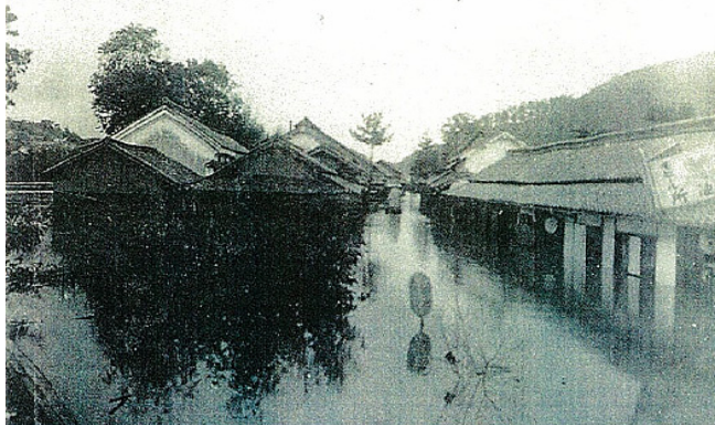
【家屋の湛水被害状況（王寺町）】
