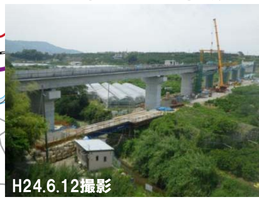
名手川高架橋上部工の工事状況
