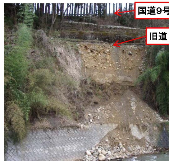
▲平成15年度の災害状況 〔国道9号法面下の旧道崩壊〕
