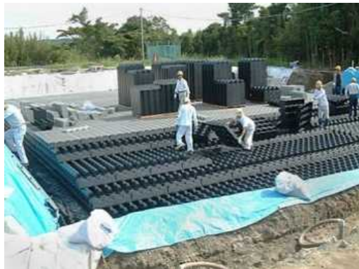
従来工法(地下空隙貯留式調整池)
