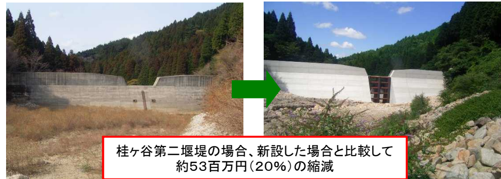
既存施設のスリット化(桂ヶ谷第二堰堤)
