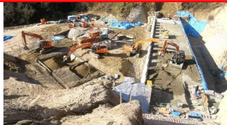
桜ヶ丘堰堤(掘削残土の利用で残土処分費を節減)
