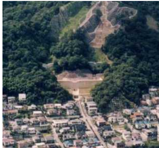
宅地の直上に設置した焼ヶ原堰堤 (住吉川水系)
