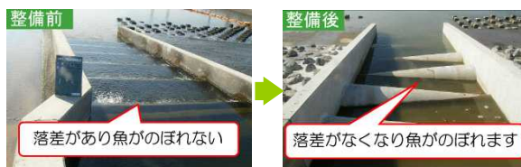
古新堰堤 (H22年度施工)
