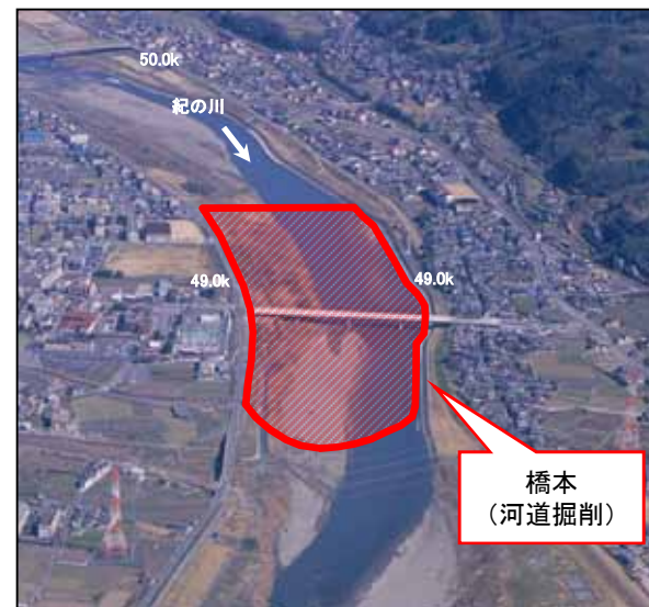
橋本地区 河道掘削
