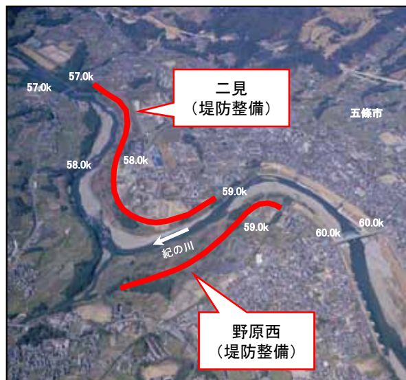
二見・野原西地区 堤防整備
