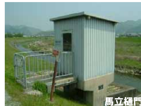
樋門等の維持管理
