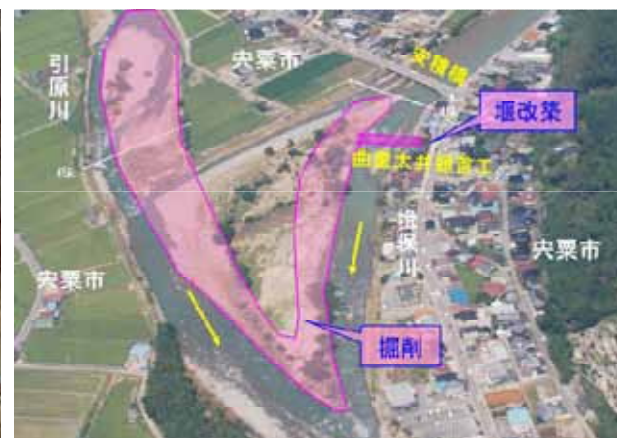
曲里地区 河道掘削・堰改築
