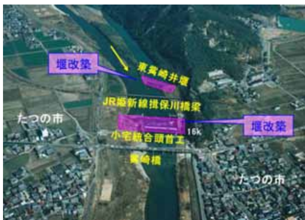
背崎地区 堰改築
