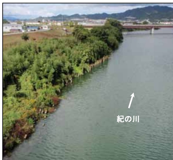
河道内樹木の伐採
