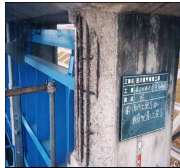
樋門等の維持管理
