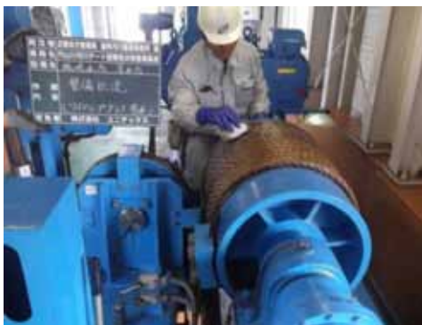
施設の点検の状況
