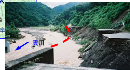
通行できなくなった国道157号(中島)
