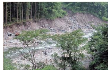
溪流内の至る所で発生した溪岸侵食
