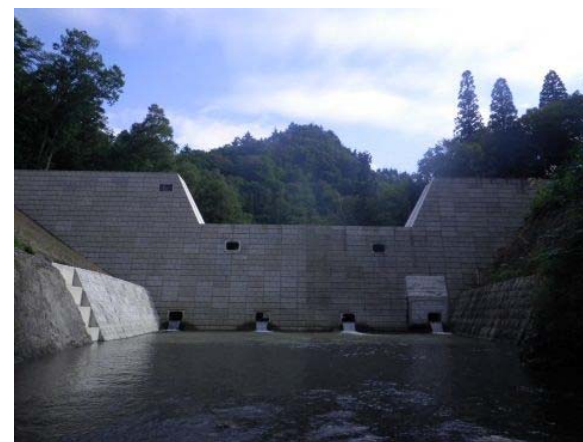
蠅帽子川第二堰堤 (平成24年11月完成)
