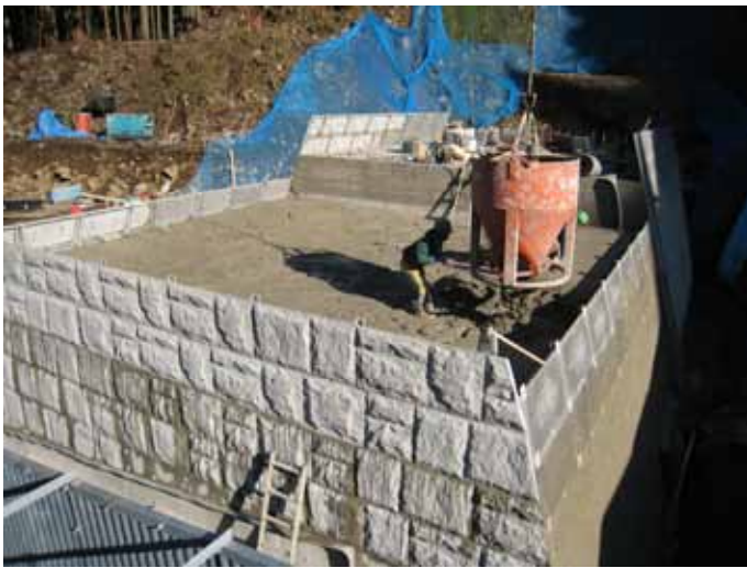
飯垣内第3砂防堰堤
