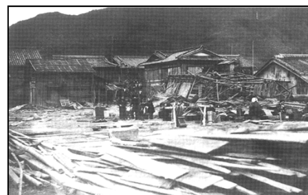
昭和南海地震の被害状況（写真はいずれも海南市）
