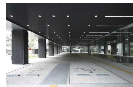
③段差のない車いす使用者用駐車場及び誘導ブロックの設置
