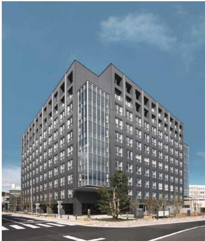
大津地方合同庁舎の整備状況(敷地南東より)
