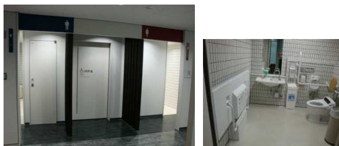
②多機能トイレを各階に設置
