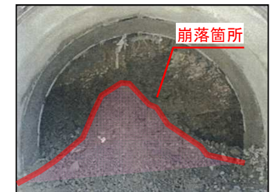
<トンネル内崩落状況写真>
