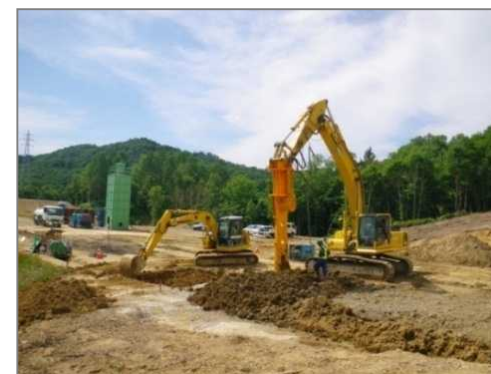
地盤改良の施工事例
