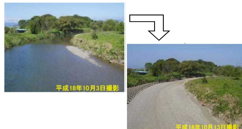
高時川の瀬切れ(長浜市難波町付近)
