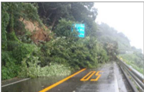
写真①: 国道8号敦賀市杉津(台風18号による通行止状況)
