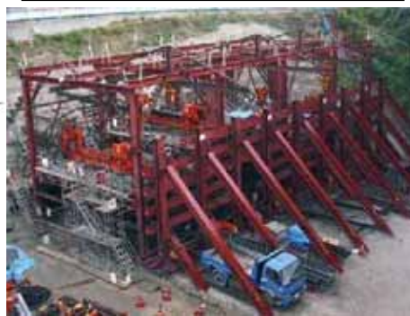
パイプルーフ推進架台全景(事例)
