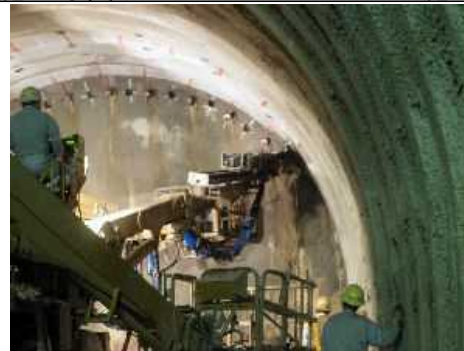
施工写真(ホイールジャンボによる施工)
