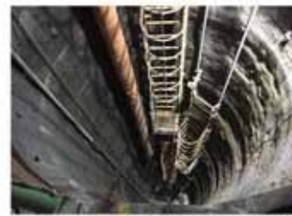
RC円柱支保工掘削内部
