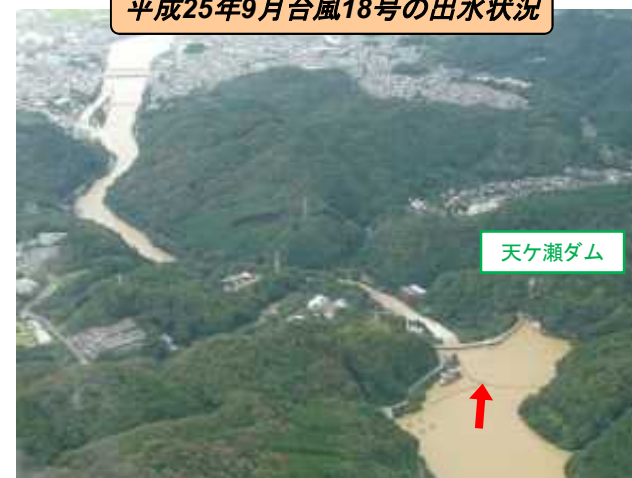
天ヶ瀬ダムから下流を望む
