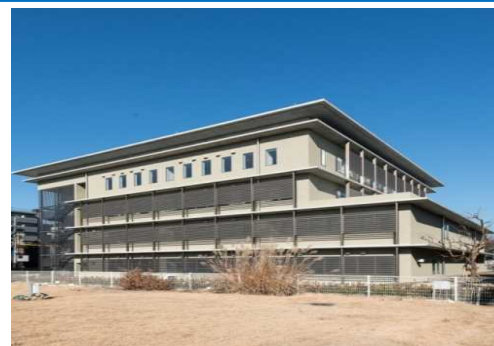
京都地方合同庁舎の整備状況
