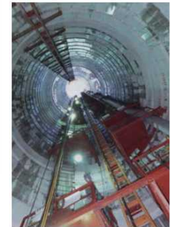
施工当時の深礎工内部
