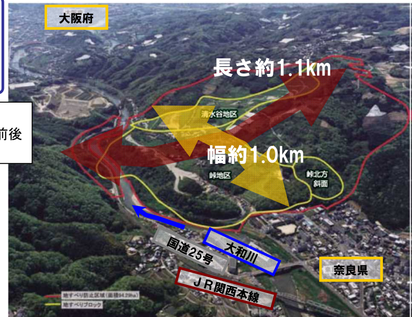
【亀の瀬地すべり全景及び諸元】
