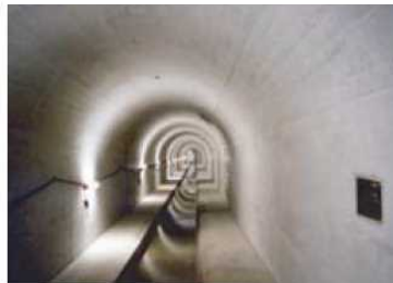
排水トンネル内部
