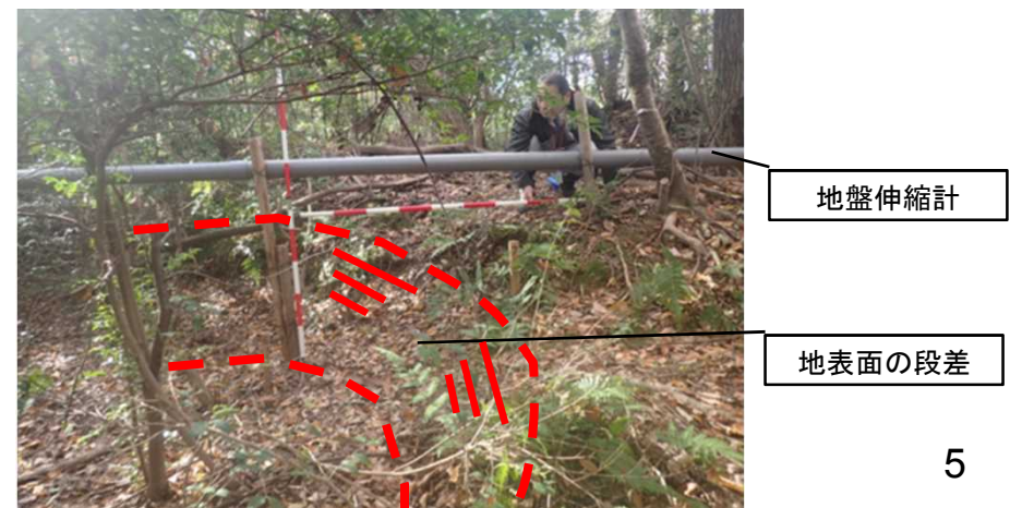
【稲葉山地区における計測状況及び 地表面の段差状況】
