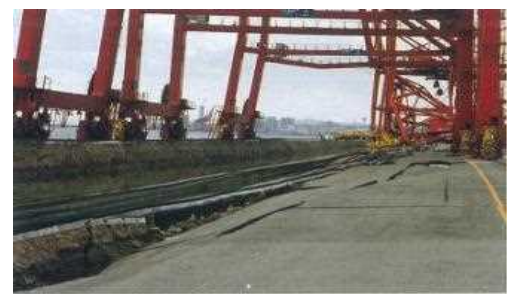
阪神・淡路大震災で被災した神戸港六甲アイランドRC-3
