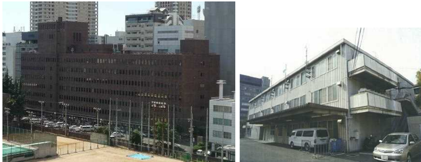
大阪第2法務総合庁舎(1977完成) 近畿管区警察局分庁舎(1993完成)
