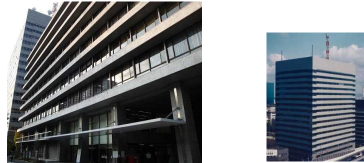
大阪第2地方合同庁舎(1968完成) 大阪第4地方合同庁舎(1993完成)
