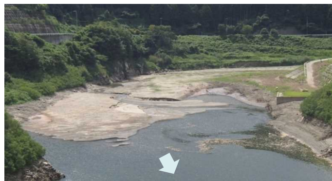
比奈知ダム上流部の堆砂の様子(H25.8撮影)：矢印は流れを示す
