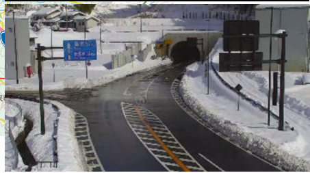
笠波トンネル南側付近
