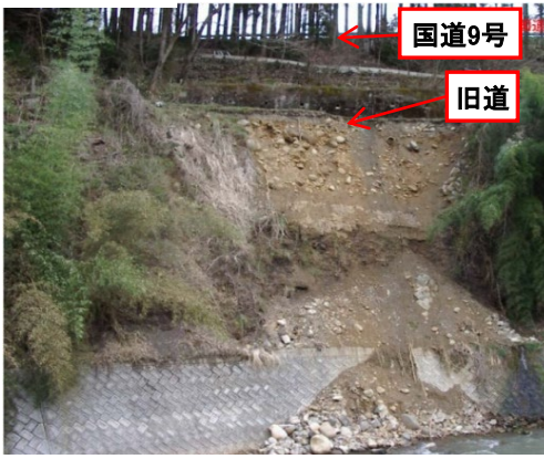
▲平成15年度の災害状況 〔国道9号法面下の旧道崩壊〕
