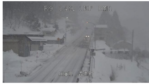
R3.1.07 事業区間内(日影地区)における降雪状況
