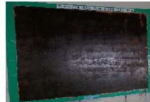
2回目剥離完了
