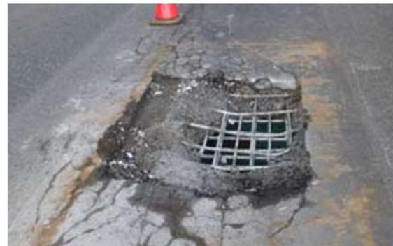
【土砂化の進行により抜け落ちた例】
