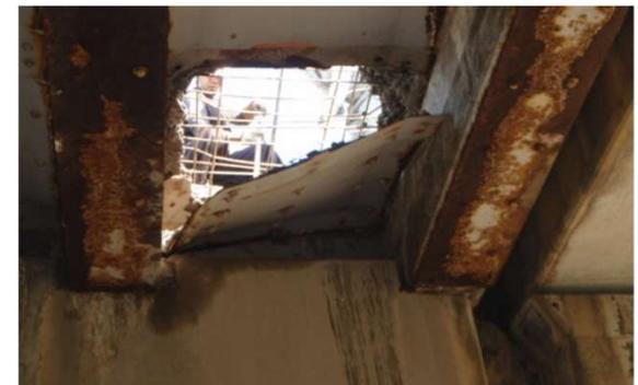
【土砂化の進行により抜け落ちた例】
