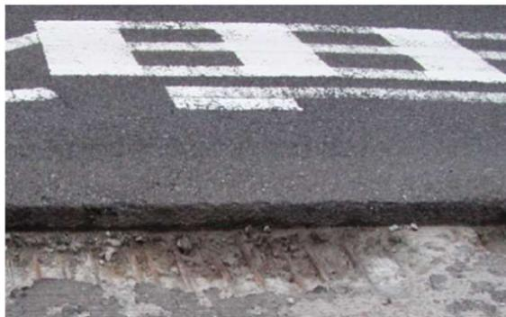
【舗装に隠れた床版上面の損傷例】
