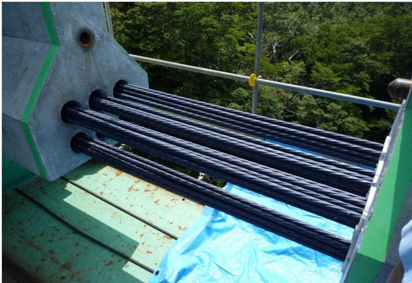
プレキャストセグメント継ぎ目部(シースの不連続部)においてもエポキシ樹脂被覆によりPC鋼より線の防食性を確保
