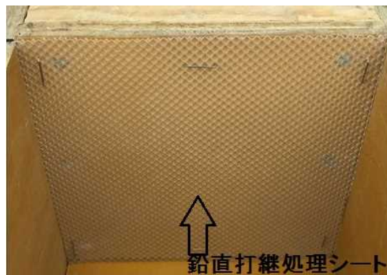
鉛直打継処理シート貼付状況 (左図a-a)
