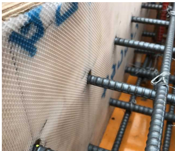
シート貼付状況
