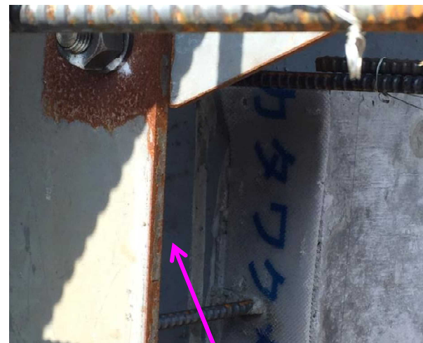
狭隘部 鋼材近接し他工法では処理難
