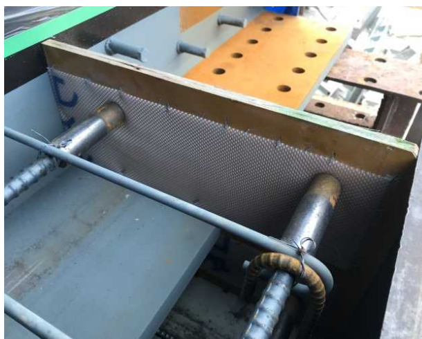
シート貼付状況
