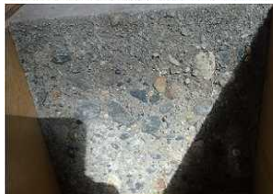
凝結遅延剤による打継面
