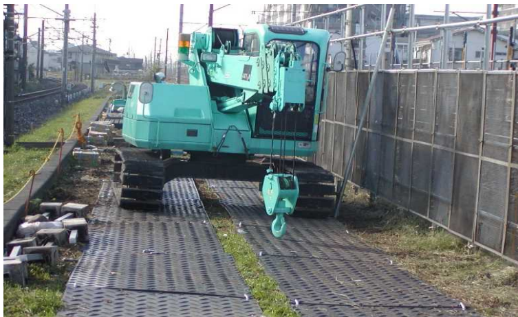
①工事現場（鉄道敷地内）
