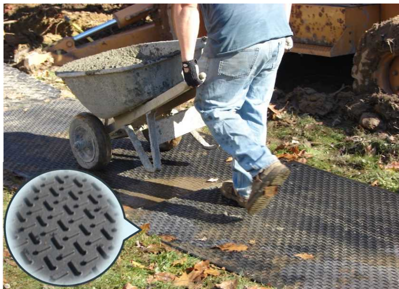
①作業員足場
