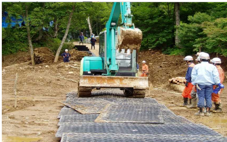
③災害復旧現場
