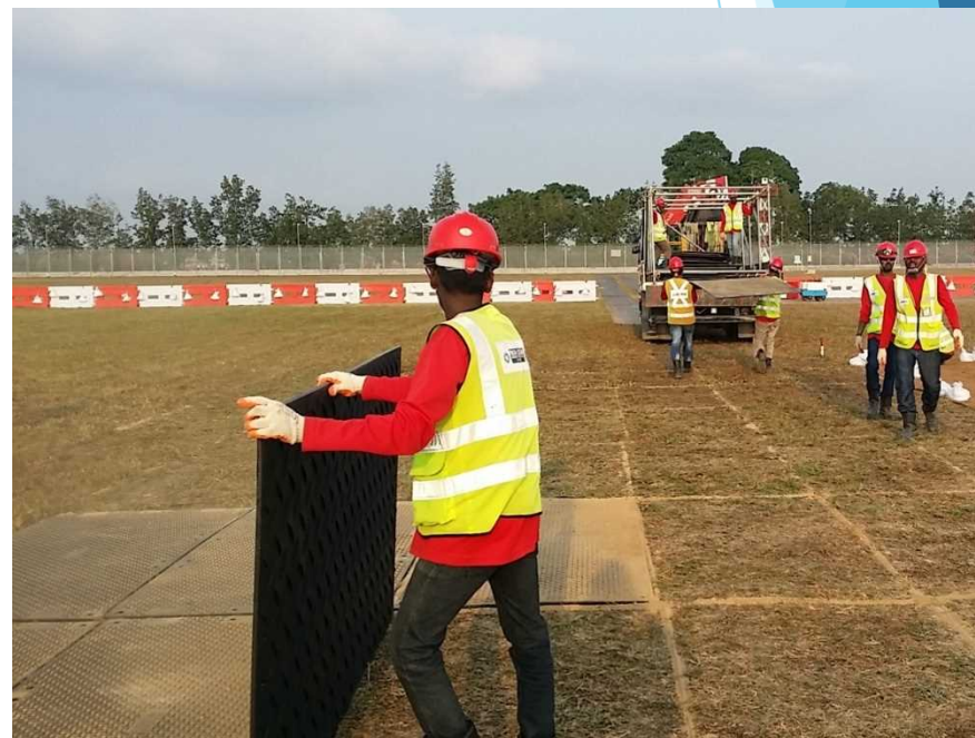
②シンガポール空港：滑走路拡張工事
