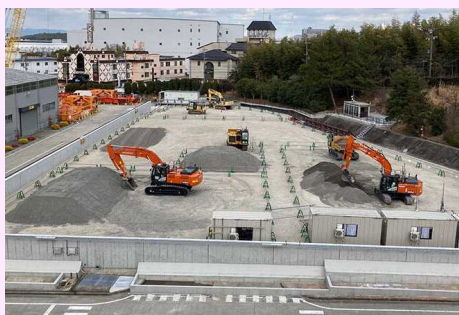
コンクリートの壁で囲われた無人化施工実験ヤード(30tの建機が衝突しても壊れない)
