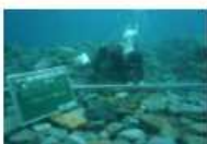
基礎捨石投入における潜水作業
