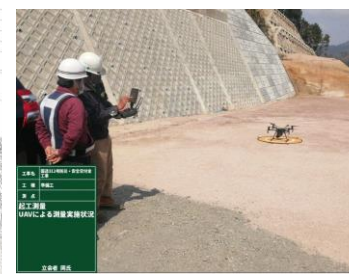
UAVによる3次元起工測量
