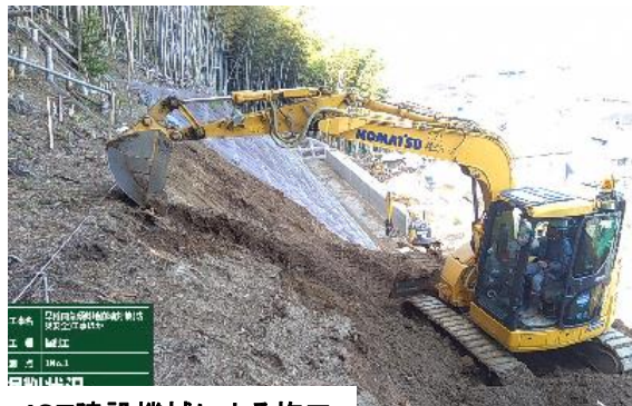
ICT建設機械による施工
