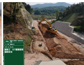
ICT建設機械による施工
