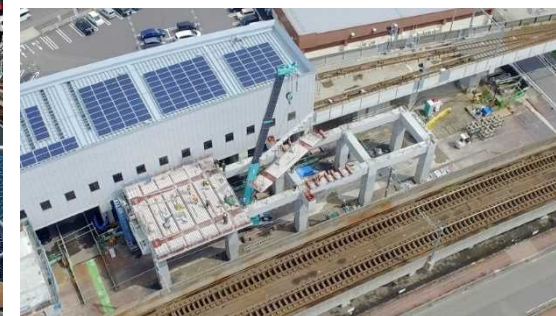
プレキャストスラブ架設状況
