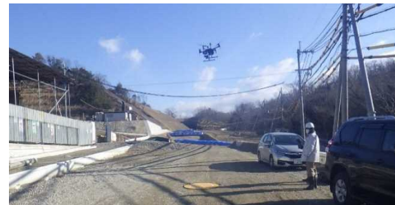
UAVによる測量
