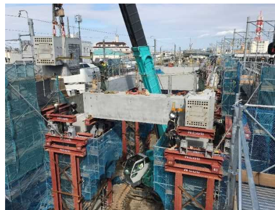
プレキャスト部材組み立て状況
