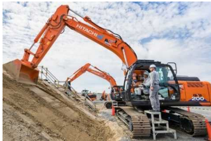
ICT建設機械の補助機能を活用し、オペレータが運転
