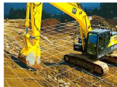
ICT建設機械による遠隔操作・無人化施工の実習
