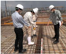
(従来) マーキング、メジャーの設置
