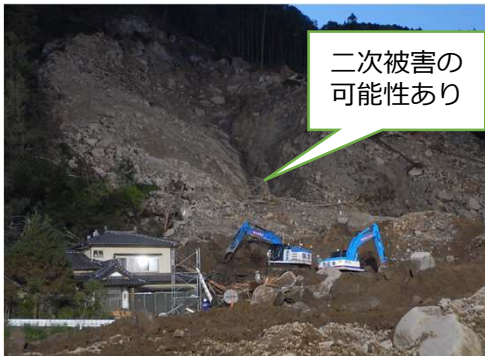
土砂崩落地による災害復旧作業
