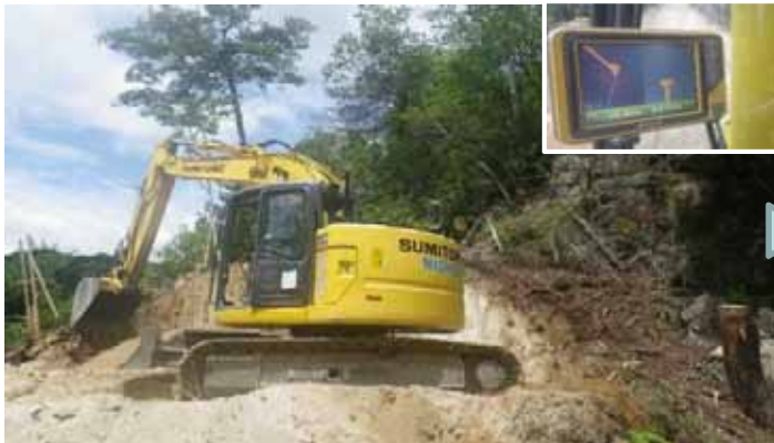
ICTバックホウでの掘削
