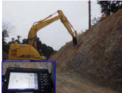
法面整形(3次元MGバックホウ)
