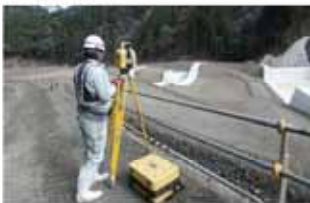
【起工測量・出来形測量】
