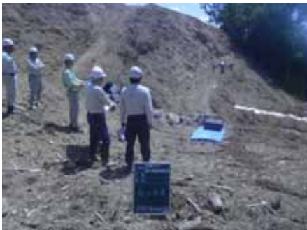
UAVによる起工測量 (6月15日撮影)
