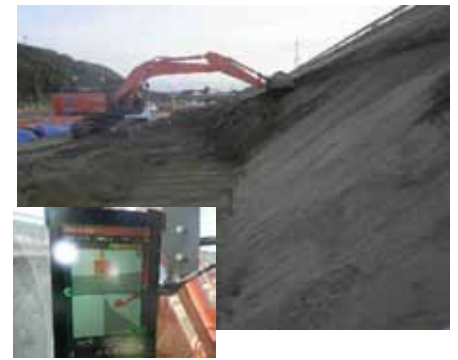
ICT掘削状況
