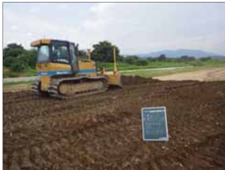
3DMGによる盛土材巻出し
