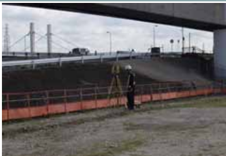
レーザースキャナーによる 起工測量
