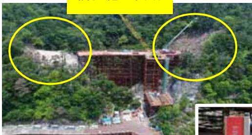
橋台施工箇所
