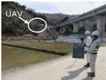
UAVによる出来形測量状況 （平成30年3月24日撮影）
