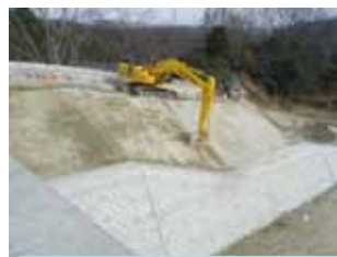
ICT建機による施工 (法面整形)
