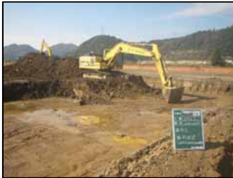
3DMGによる掘削
