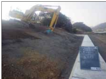
ICTバックホウによる法面整形
