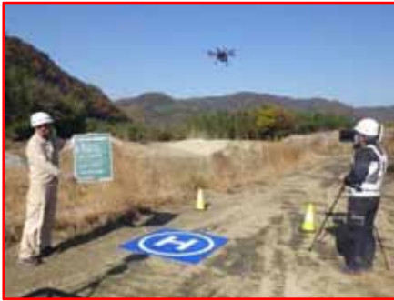
UAVによる出来形観測
