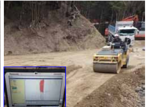
GNSSによる締固め回数管理
