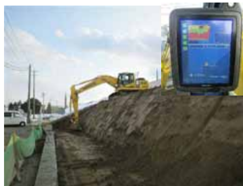
【3D-MCバックホウ施工】
