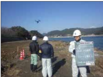
UAVによる起工測量
