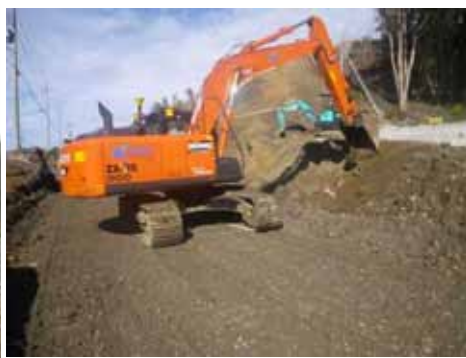
法面整形(3次元MGバックホウ)
