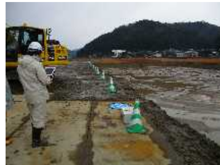
UEVを用いた出来形測量
