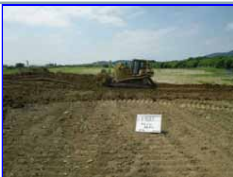
MGブルドーザ施工状況
