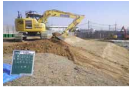
MCバックホーによる法面整形工
