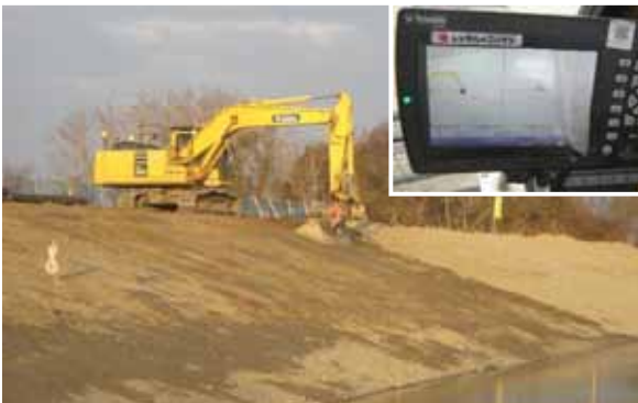
MGバックホウによる法面整形
