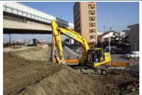
ICTバックホウによる 法面整形
