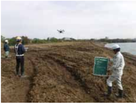
UAV起工測量状況
