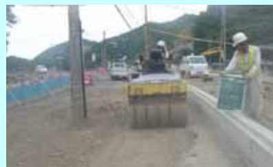
MG搭載コンバインドローラによる盛土締め
