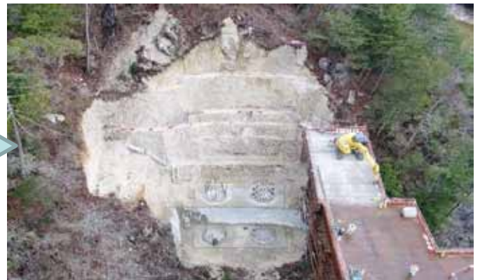
複雑な掘削形状でもICT土工で施工可能となります。
