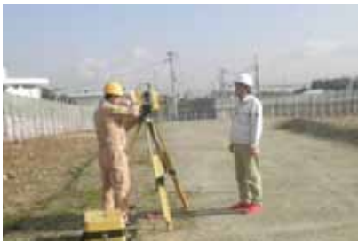
3Dレーザースキャナーによる 起工測量
