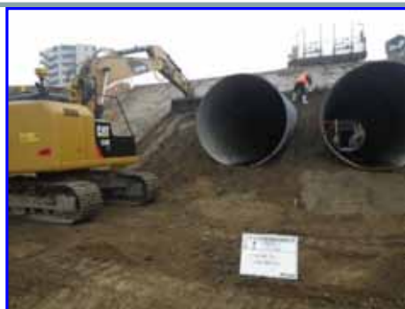
MGバックホウ施工状況
