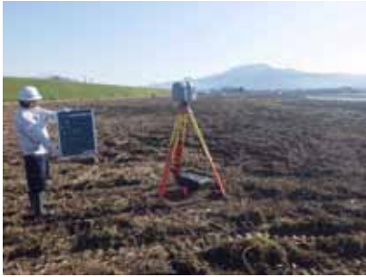
レーザースキャナによる起工測量
