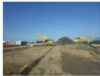
□ MCバックホウによる施工状況
