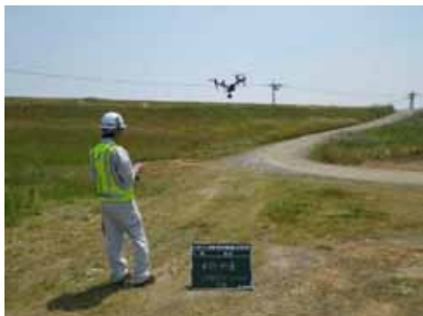
【UAVによる起工測量】
