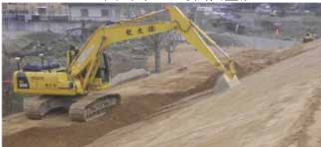
MGバックホウによる法面整形
