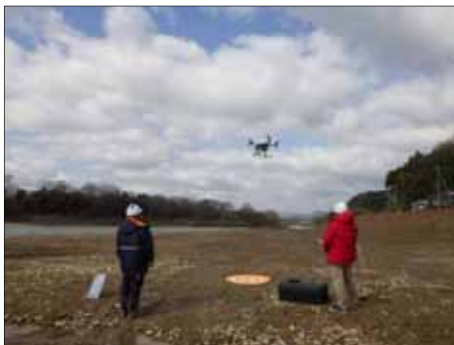
UAVによる出来形測量
