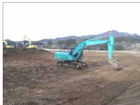
3DMGによる河道掘削
