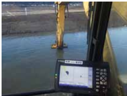
MGバックホウによる水中掘削状況
