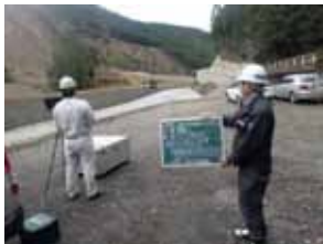
UAVによる起工測量
