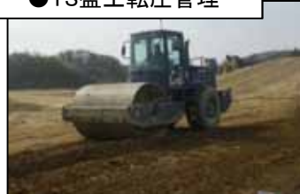
●TS盛土転圧管理
