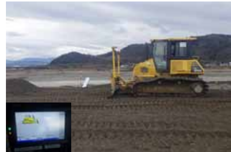
MGブルドーザによる盛土状況
