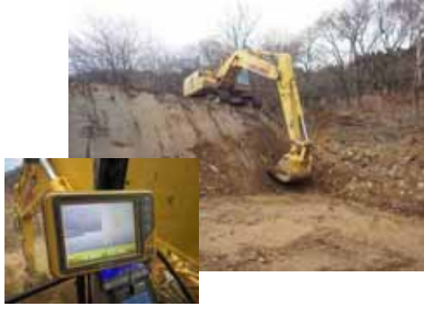
ICTバックホウによる掘削状況
