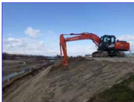
ICTバックホウによる法面整形 (1月24日撮影)
