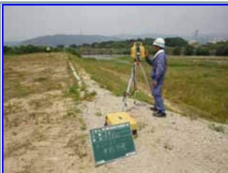
TLSによる起工測量
