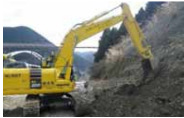
MGバックホウによる法面整形
