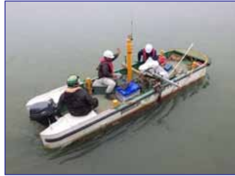
マルチビームによる出来形測量
