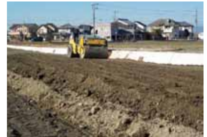
転圧システム活用
