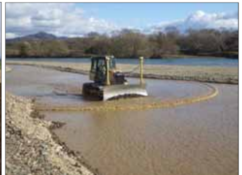
3DMGによる河道掘削
