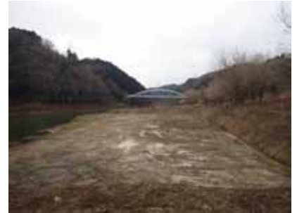
ICTバックホウによる掘削範囲
