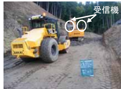
MGバックホウによる敷均し、 TS・GNSSによる締固め回数管理状況 （平成29年11月10日撮影）
