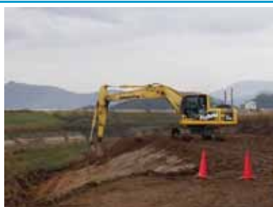
MGバックホウによる 切土法面整形
