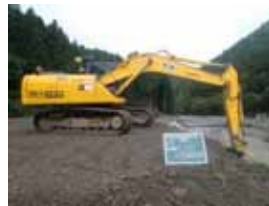
ICTバックホウによる 法面整形状況
