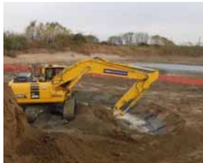
MCバックホウによる掘削状況
