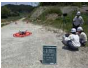
UAV起工測量
