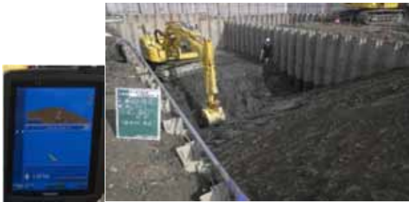
MCバックホーによる掘削工
