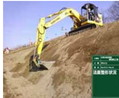
ICT施工状況
