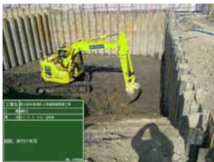
MCバックホウによる掘削状況
