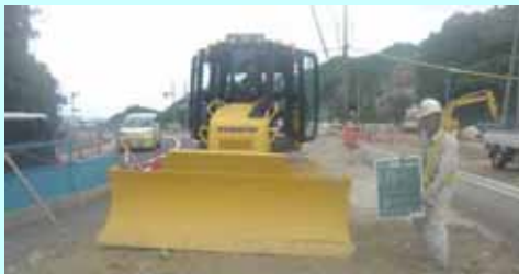
MC搭載ブルドーザによる盛土敷均し
