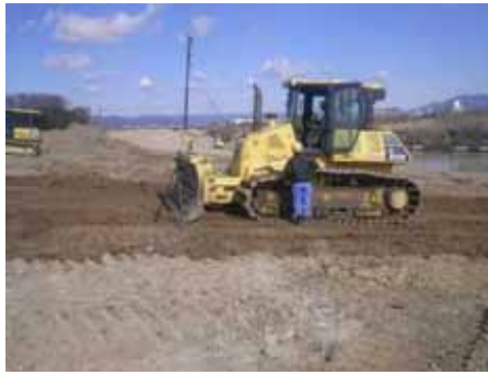
ICT建設機械の活用 (操作方法の説明と実施)
