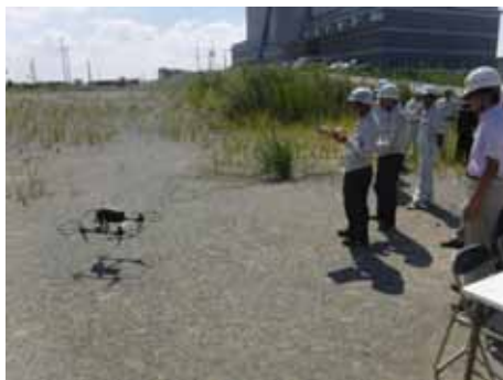
UAVによる起工測量
