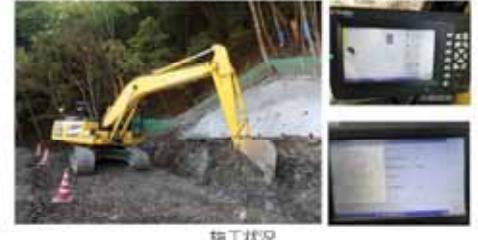
【ICT建設機械による施工】
