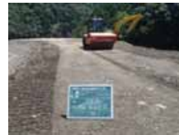
ICTローラーによる 転圧状況
