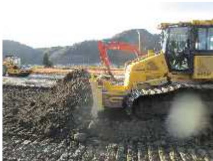
3DMGによる掘削
