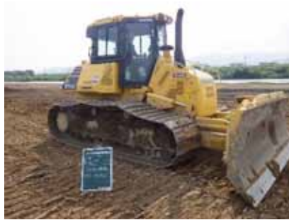
ICT建機による施工(MCブルドーザ)
