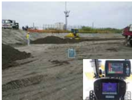
ITCブルドーザーによる敷き均し
