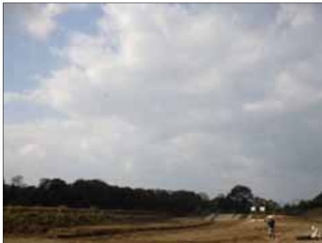
UAVによる起工測量
