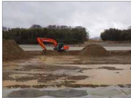
3DMGによる河床掘削
