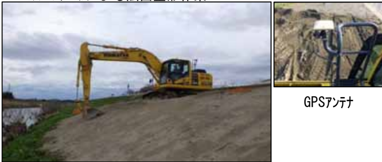
マシンコントロールによる法面整形作業
