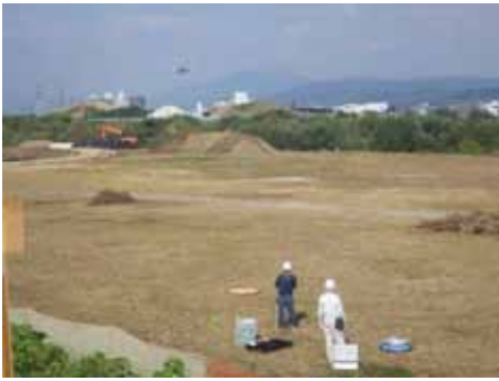
UAVによる施工前測量 (10月11日撮影)
