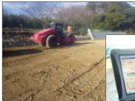
ICTローラーによる 締固め管理
