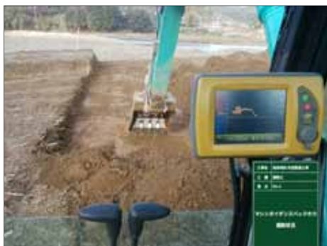
3DMGによる河道掘削
