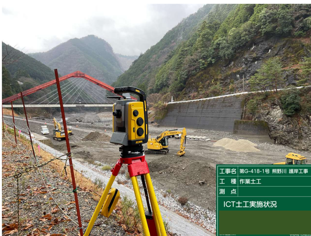
ICT施工状況
