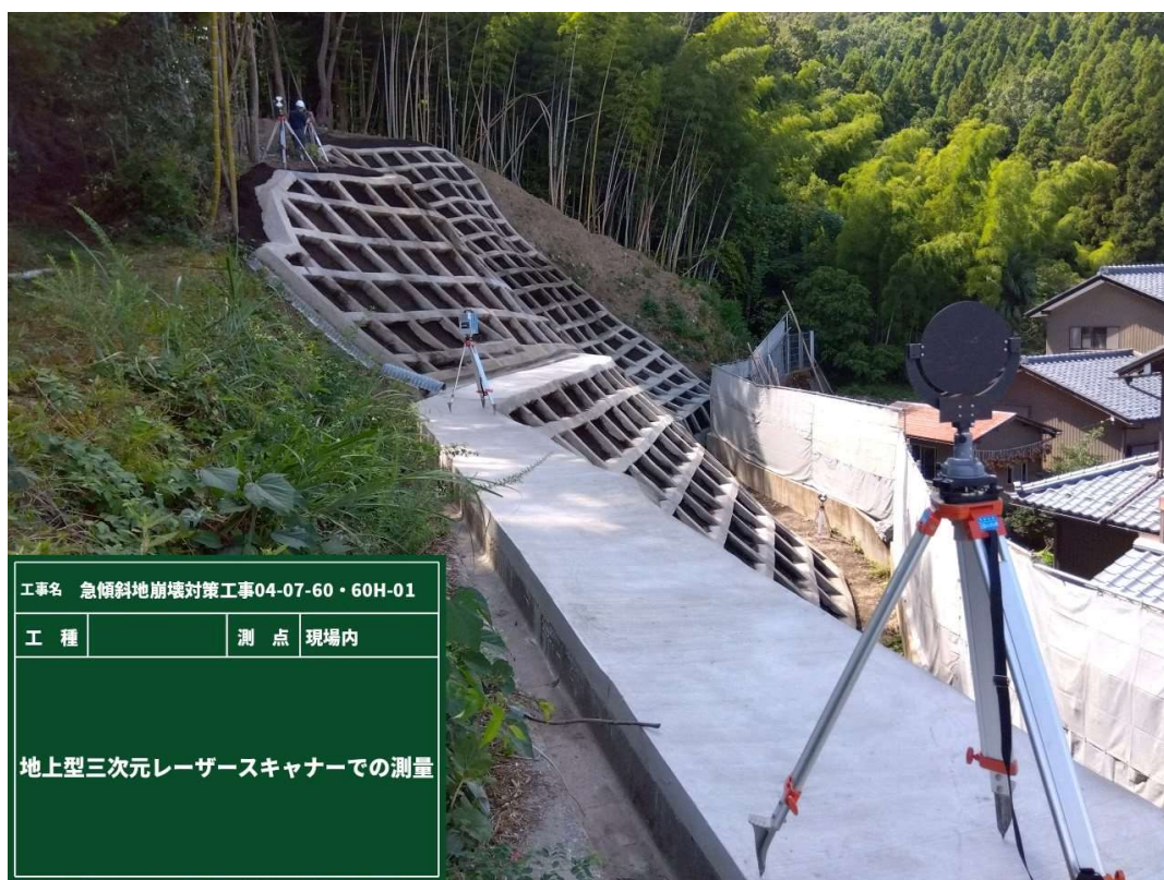
出来形計測（レーザースキャナー）
