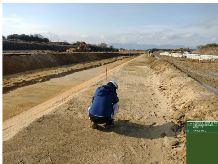
出来形計測（検証） （左：検測状況 右：検測結果）
