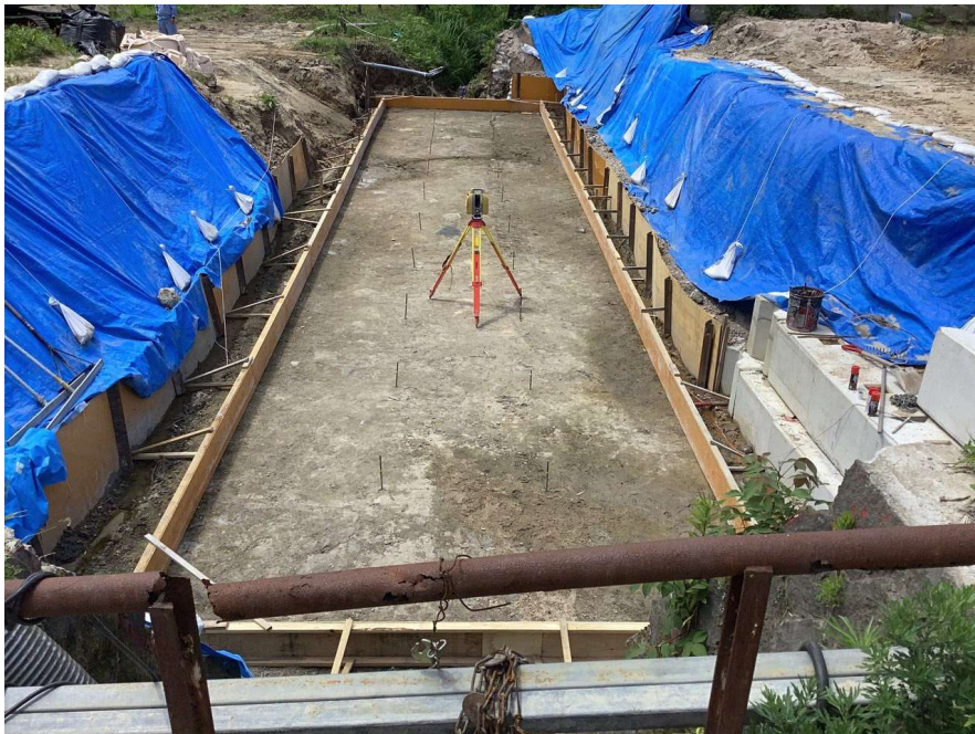
出来形計測 (レーザースキャナー)
