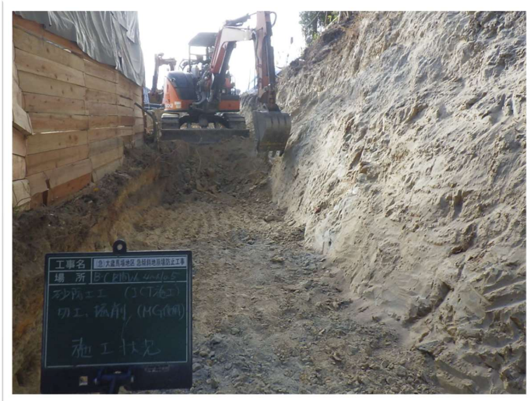
掘削状況（ICT建機）
