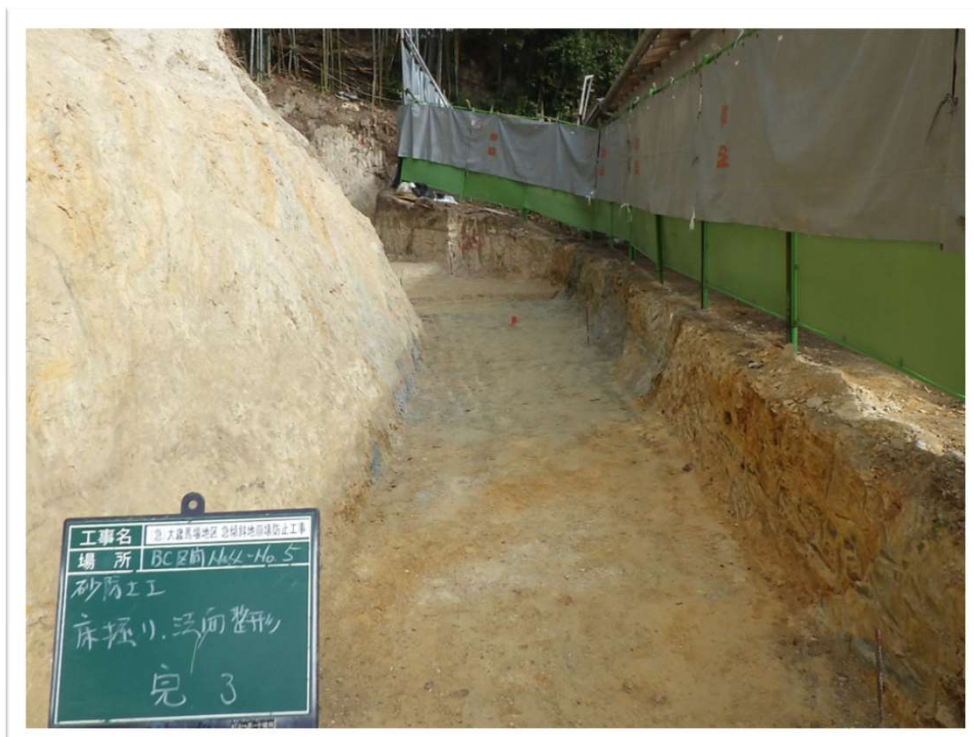
ICT施工完了状況
