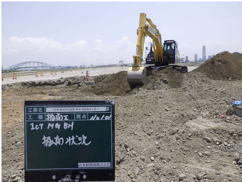
ICT建設機械MGバックホウ (左：施工状況 右：施工中のモニター画面)
