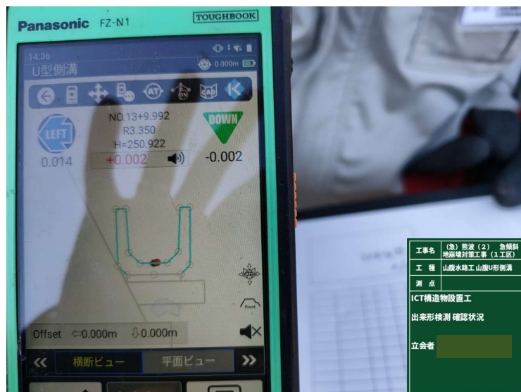
出来形検側状況 (U字側溝)
