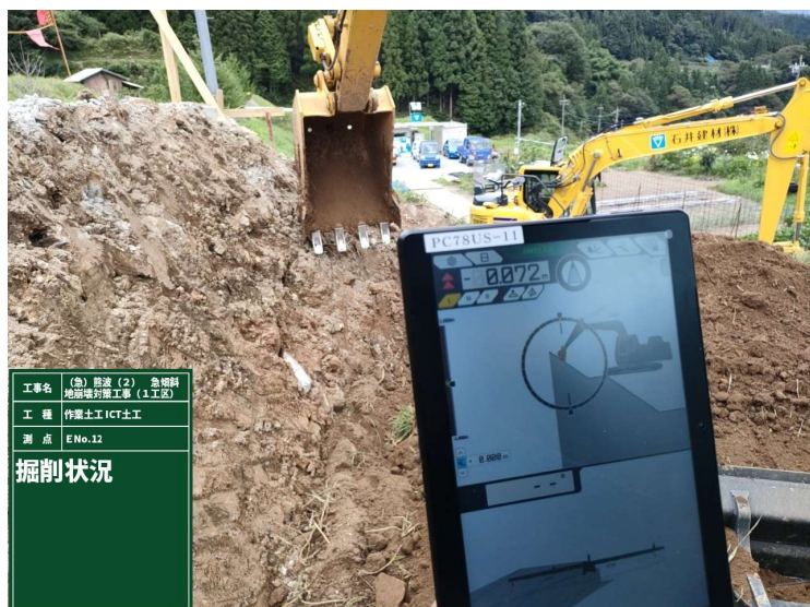
掘削状況 (ICT建機)
