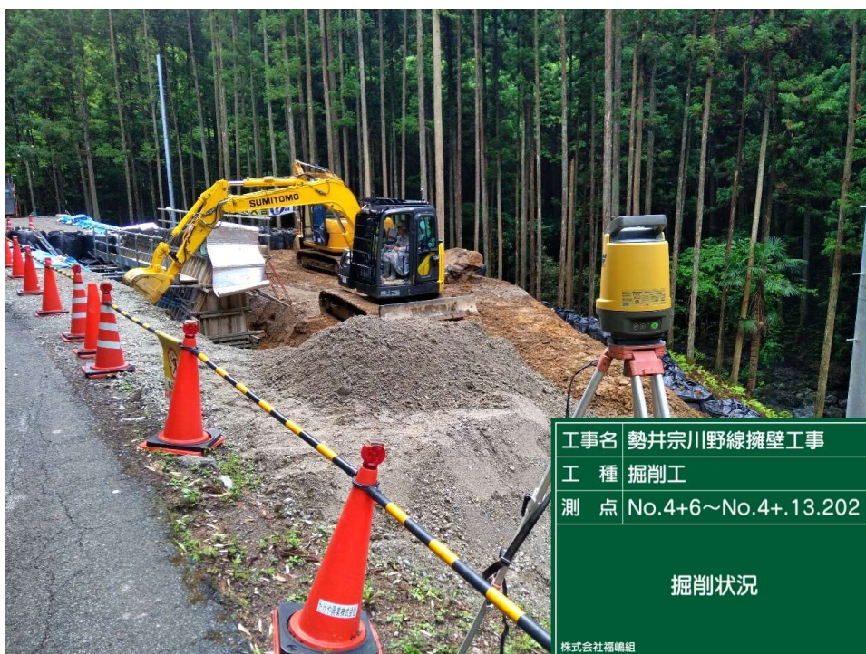
ICT施工状況
