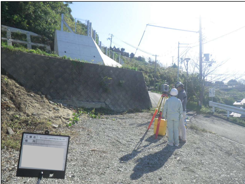
起工測量 (レーザースキャナー)
