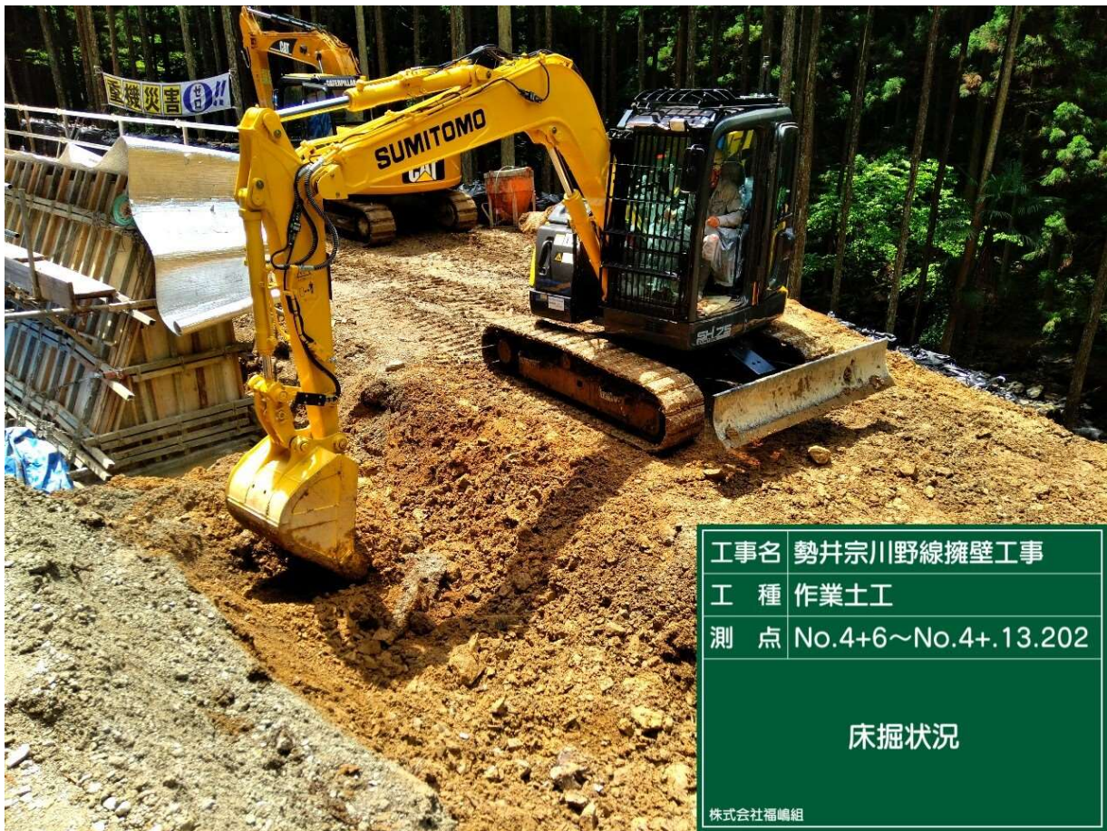
ICT建設機械MGバックホウ
