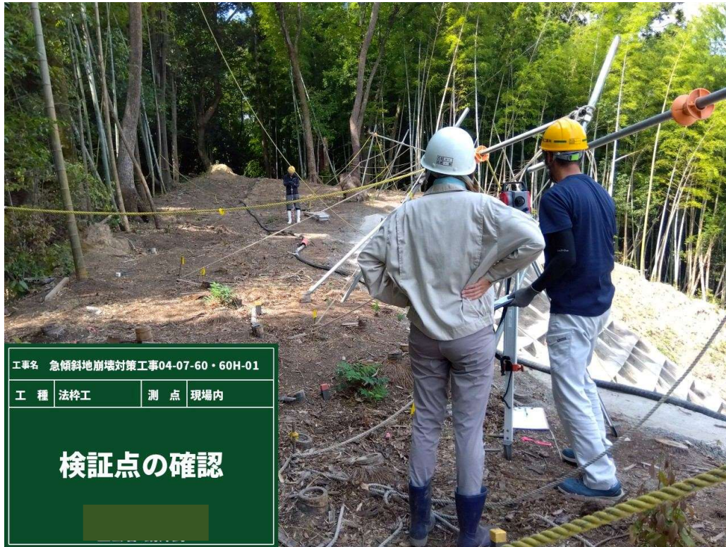
出来形計測（検証点の確認）
