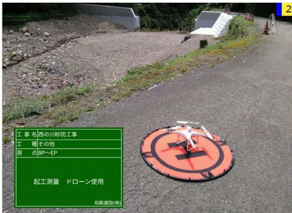
起工測量 (UAV)
