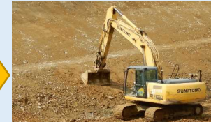
法面整形（ICT建機）
