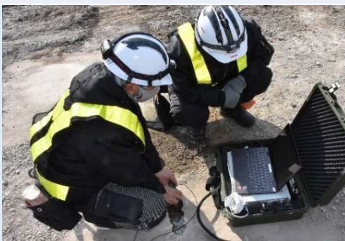
図-1 現場計測（床版上面から計測中）
