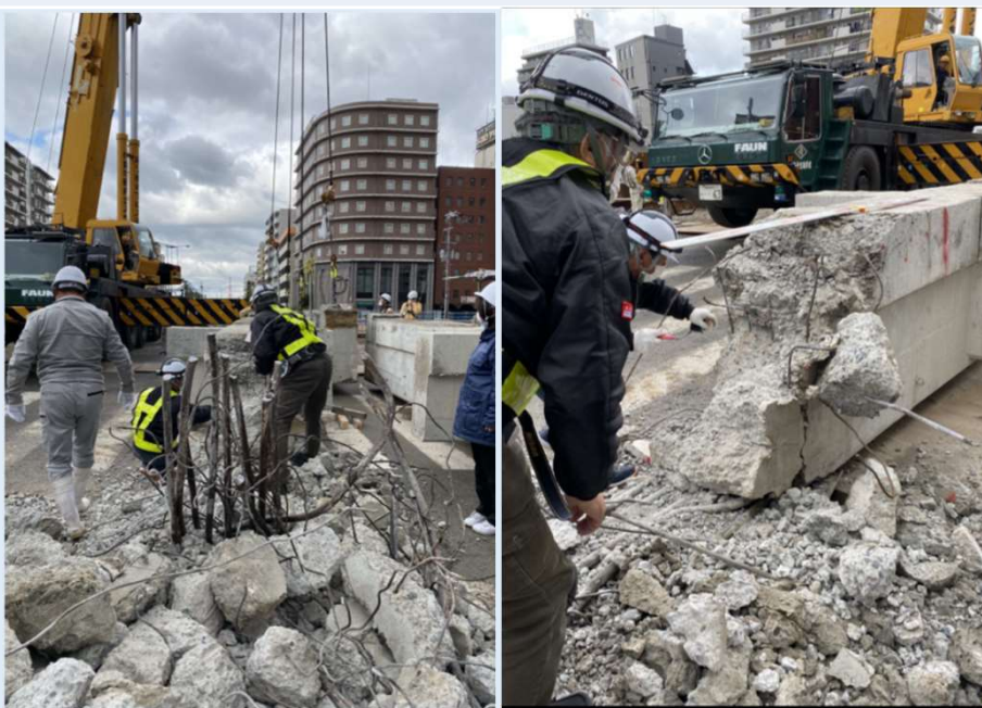
図-2 現場確認（鉄筋位置、径の確認中）
