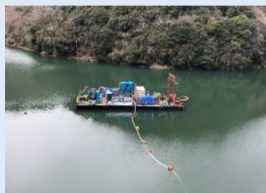
作業台船全景
