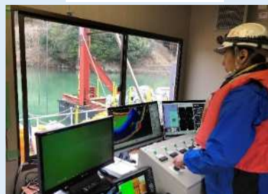
施工状況（ICT施工）
