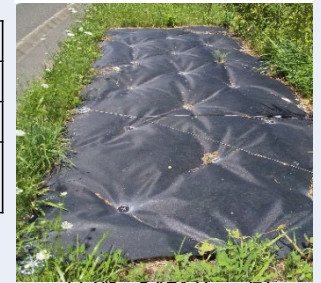
技術の試験施工例
