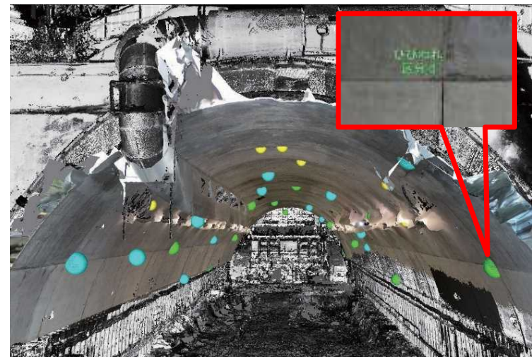
調査時期による損傷の仕分け (※)
