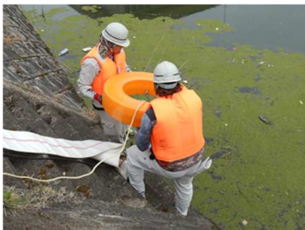
ポンプを水中へ運搬する様子
