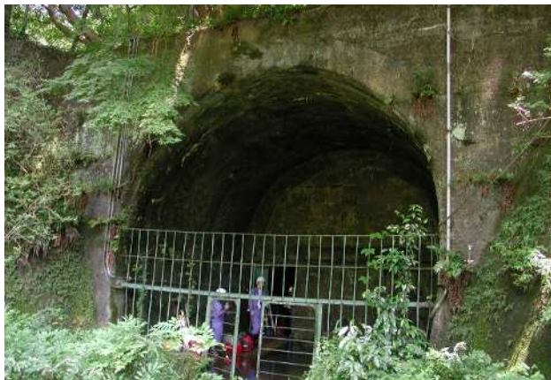
旧志津川導水路吐口部状況（土砂災害前）
