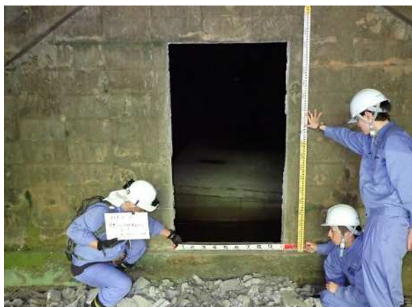
旧志津川導水路吐口 開口部状況
