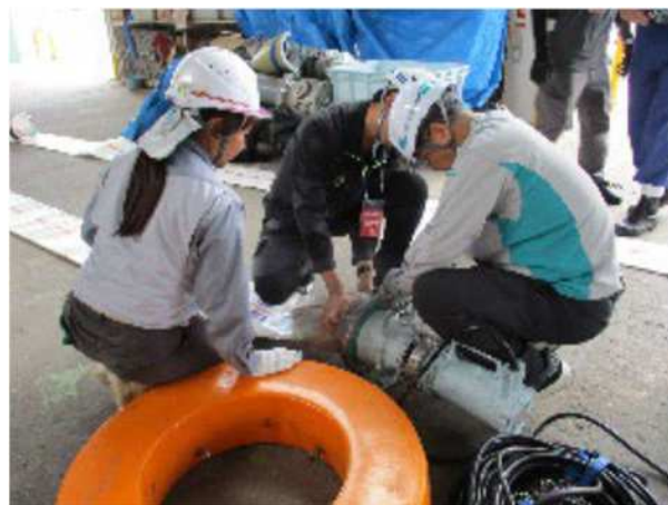
水中ポンプにホースを接続する様子
