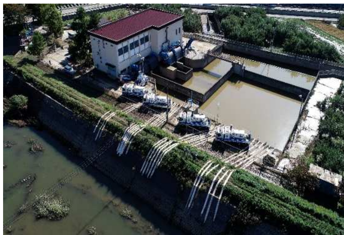
排水ポンプ車の設営状況
