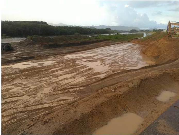
【雨天後の現場状況写真】
