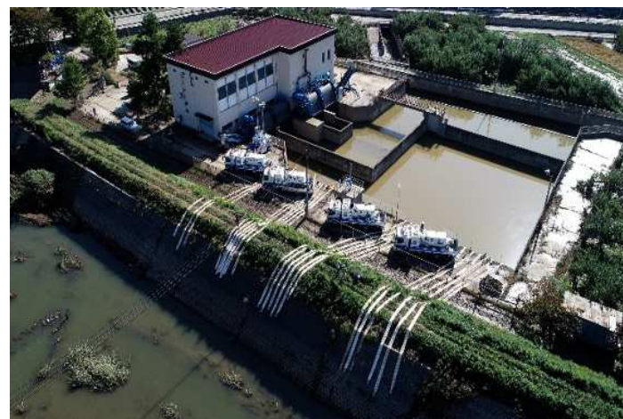
排水ポンプ車と土堤と水面の位置
