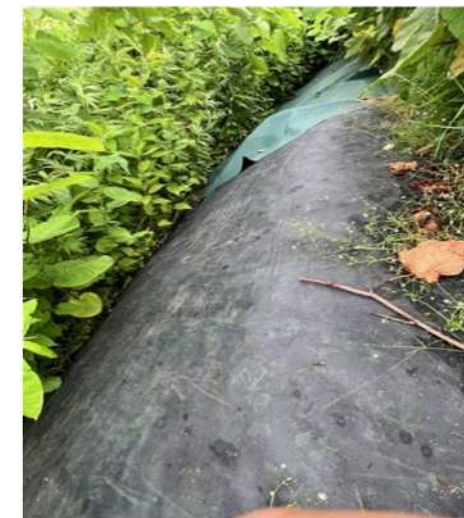
北海道幌加内町国道275号線 試験施工場所 (施工後1年経過)
