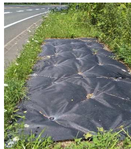
北海道仁木町国道5号線 試験施工場所 (施工後1年経過)
