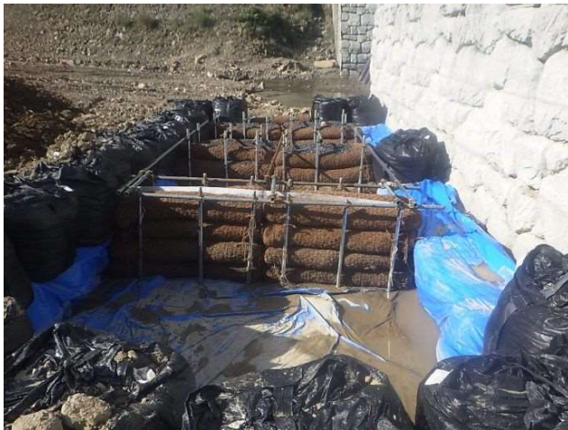
○写真（濁水を排出させない技術）
