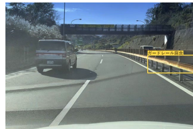
図-6 ガードレールの不具合検知例
