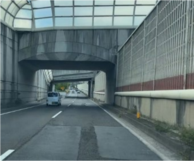
図-10 部分補修の箇所
