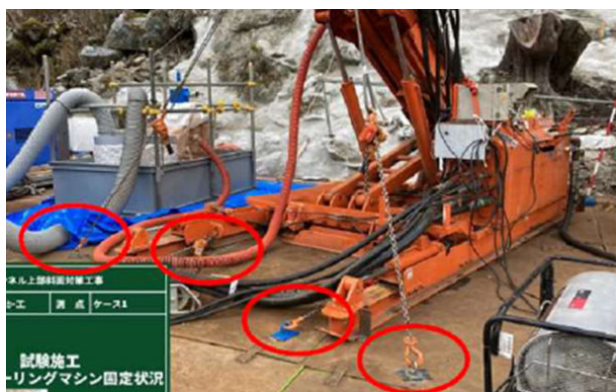
写真-2 削孔機固定状況
