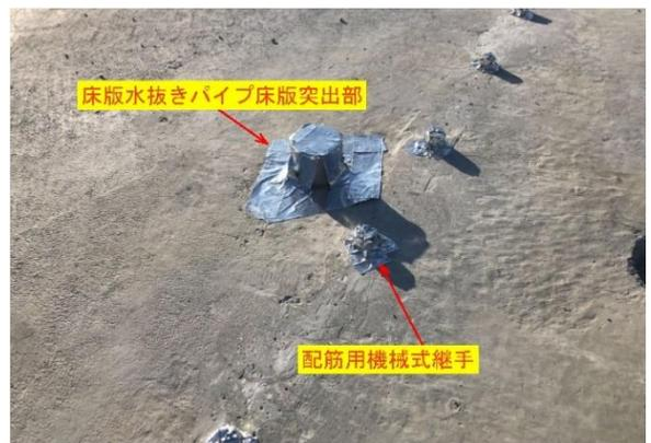
写真-6 機械継手養生状況
