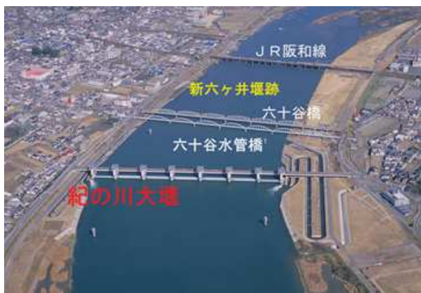
図-1 紀の川大堰全体写真
